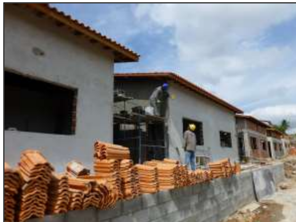
Estado das obras, out. 2015. Fonte: MICI
