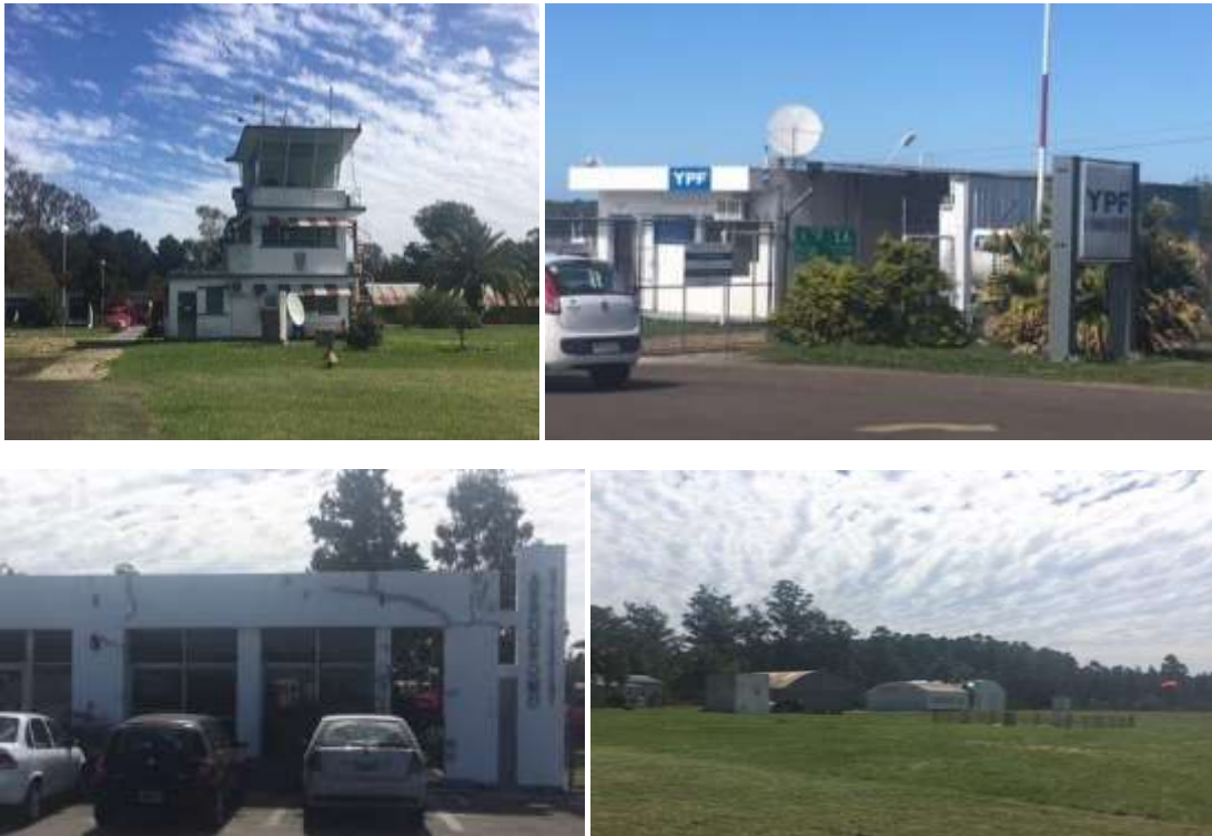
Figura 6 – Infraestructura existente. Fuente: Elaboración propia
