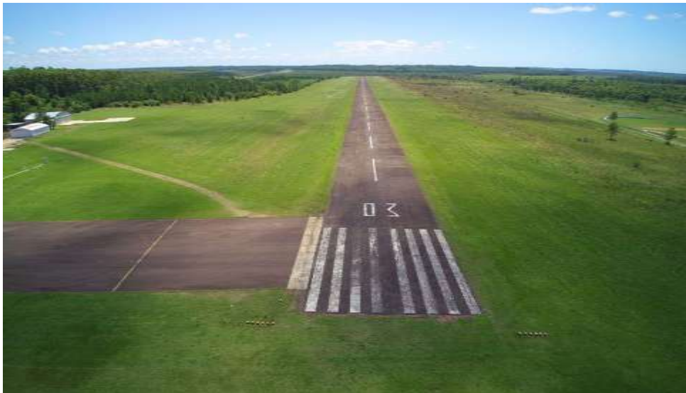
Figura 3 – Vista aérea del estado de la pista. Fuente: Aeropuerto de Concordia
